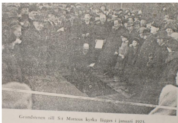
Bild 8. Grundstensläggning i januari 1923. [6]
