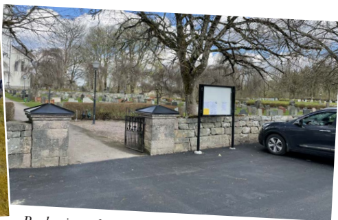
Parkeringsplatsen vid Himmeryds kyrkogård har asfalterats, liksom vissa partier vid kyrkans ingång.
